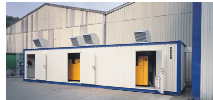
从测算到包装、待运行，凯撒为在奥地利，Jennersdorf的Vossen AG公司定做的——新型德国凯撒压缩空气系统，以一个40尺集装箱装的成套系统。
